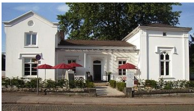
Die Villa Bozi wurde 1852 von dem Textilfabrikanten Carl Bozi im irischen Landhausstil erbaut. Jetzt ist sie renoviert und bietet Raum für Veranstaltungen. Foto: Villa Bozi, Bielefeld
